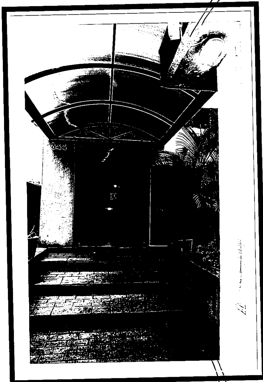
Vista da entrada do Edifício Maison Nice.
