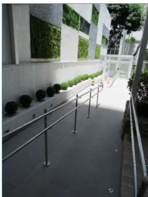
Foto de nº 07- Acesso ao edifício.
