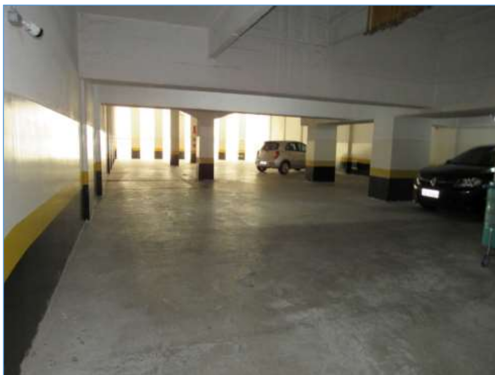
Foto de nº 11 – Subsolo.
