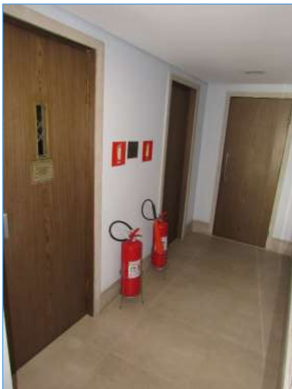
Foto de nº 10 - Hall do elevador.
