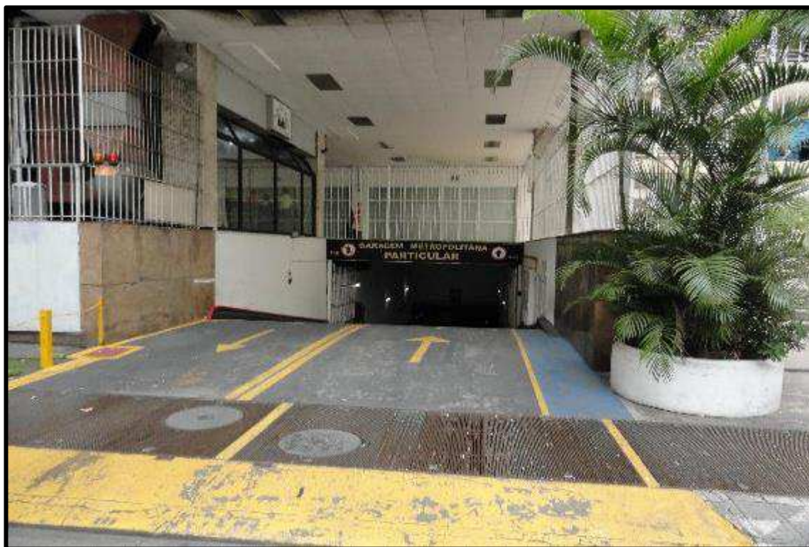
FOTO 6 – Vista do acesso às garagens.
