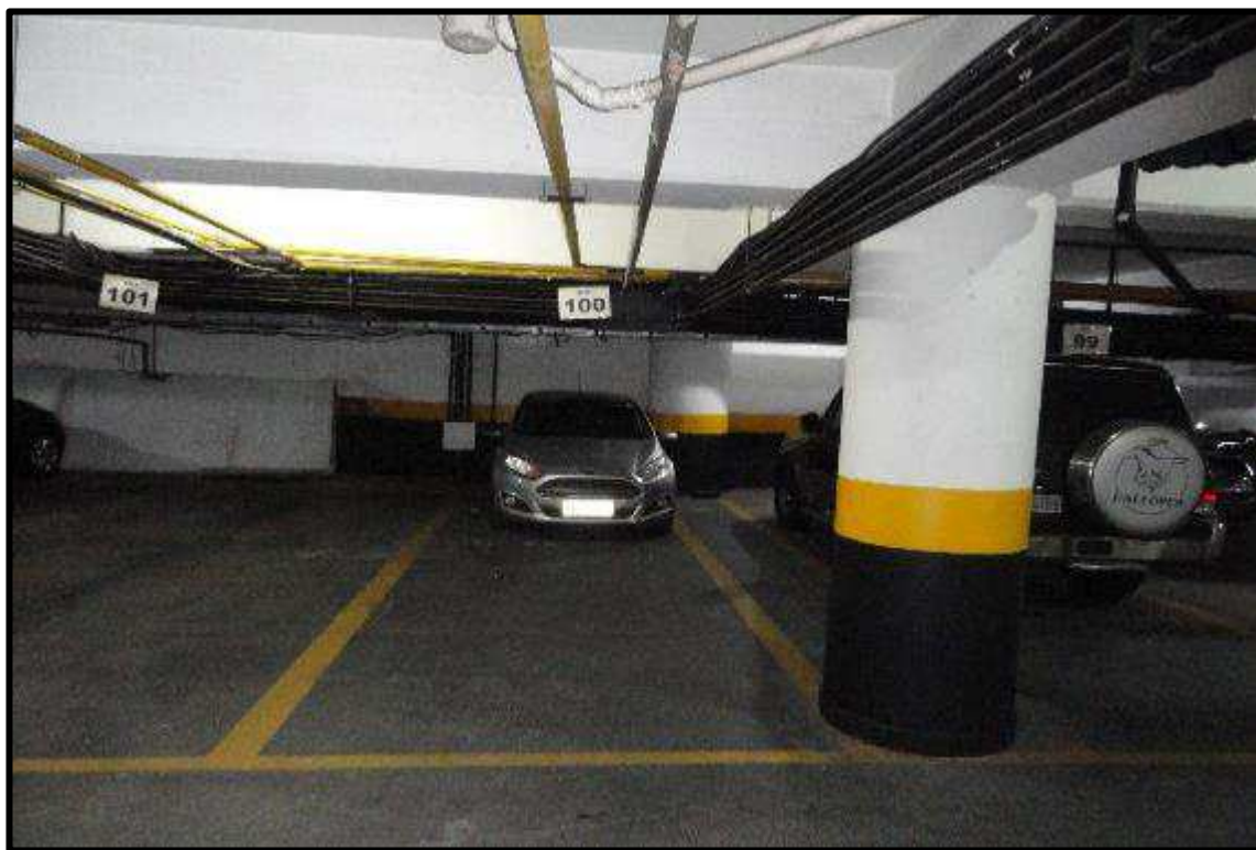
FOTO 17 – Vista frontal do box (vaga) nº 100.
