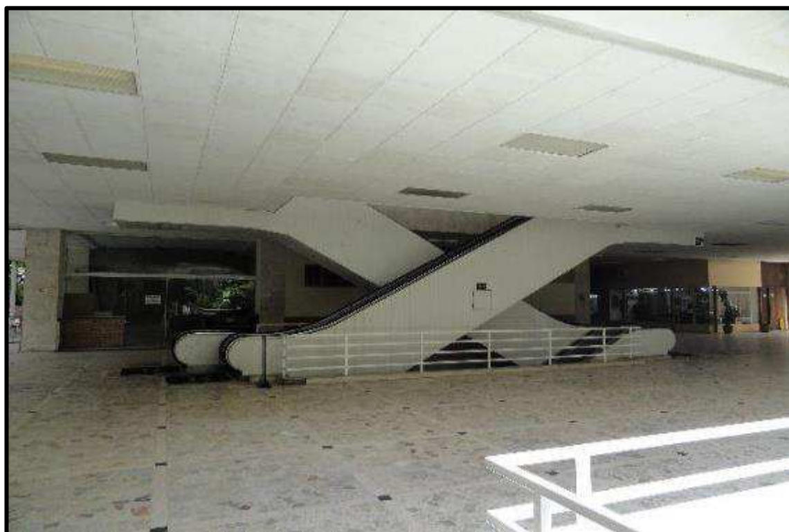
FOTO 14 – Vista das escadarias de circulação da galeria.
