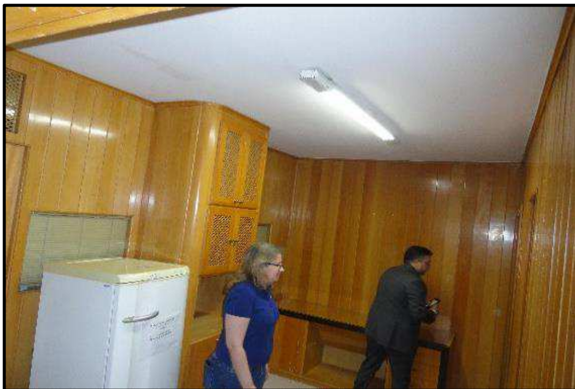
FOTO 33 – Vista das salas existentes.
