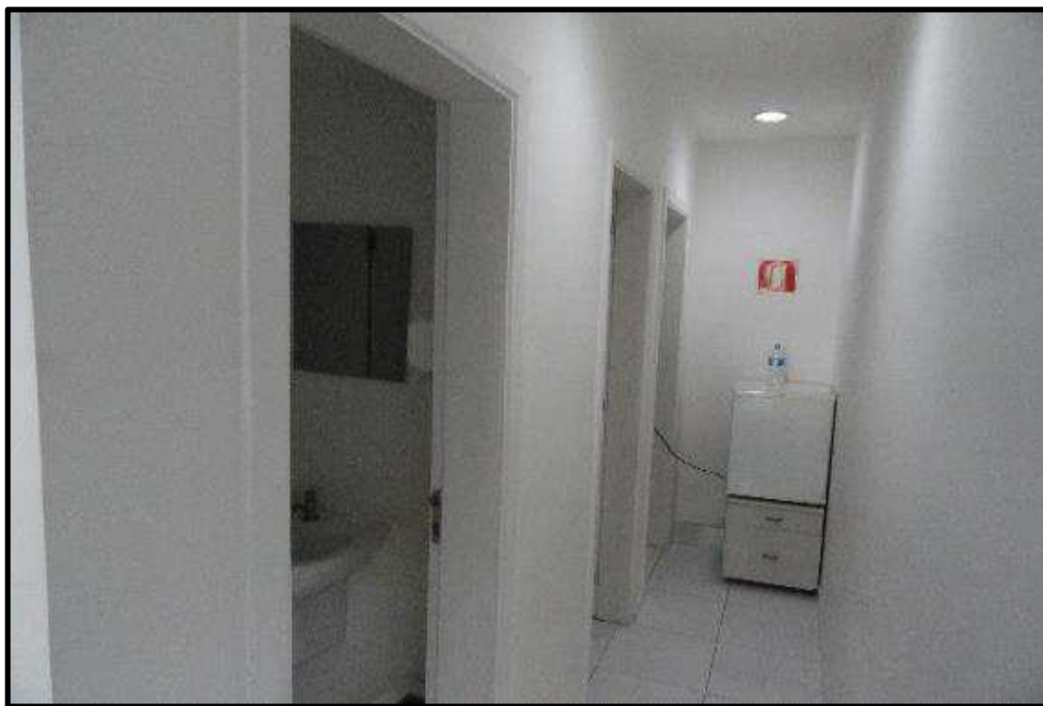
FOTO 29 – Vista do acesso aos banheiros.
